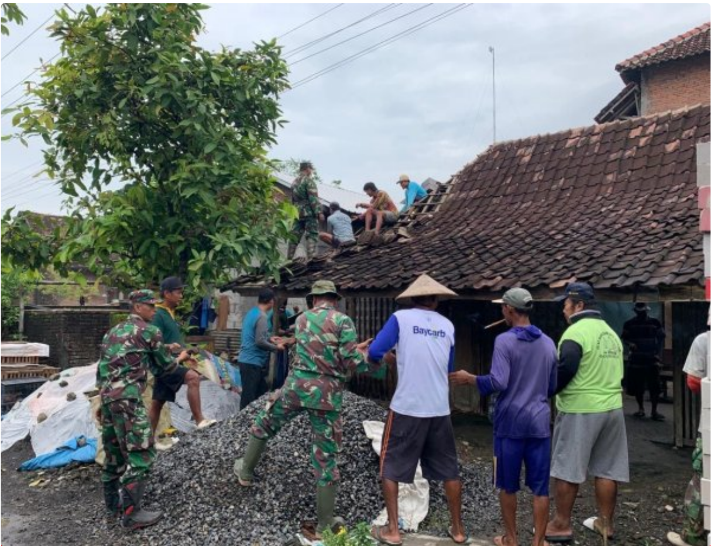
Proses pembongkaran rumah warga penerima RTLH dalam TMMD ke 123
